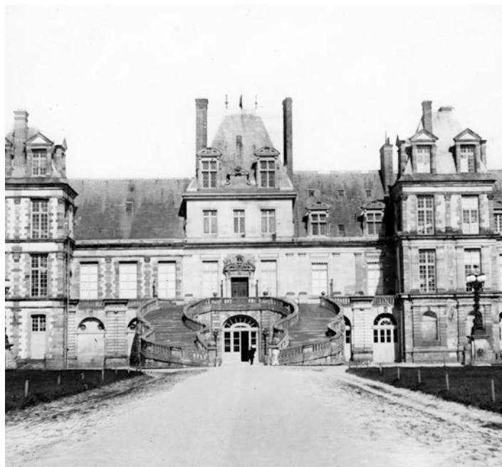
_ 58 Fontainebleau : La cour des adieux et son double escalier (Source EHNE )
