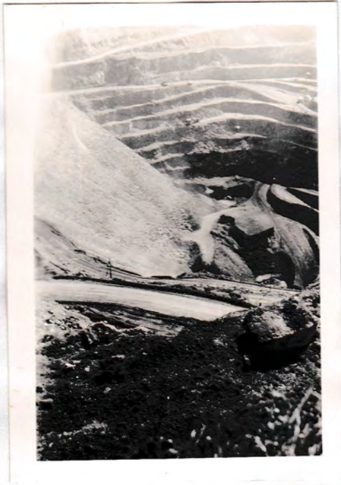
Les Décharges au Nord de la Découverte dans la partie déhouillée
